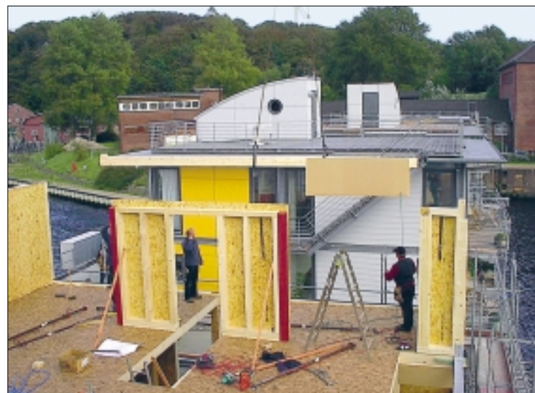
Wasserhäuser aus Fertigteilen in ökologischer Holzständerbauweise.
